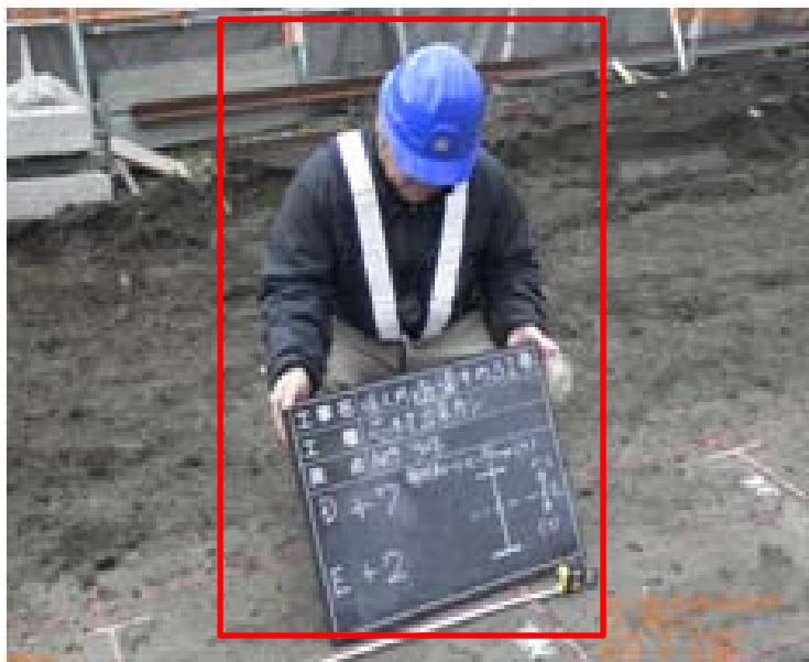
図：現在の工事写真
