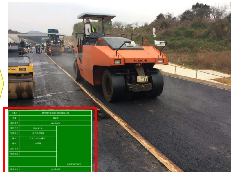
図：試行現場の工事写真
