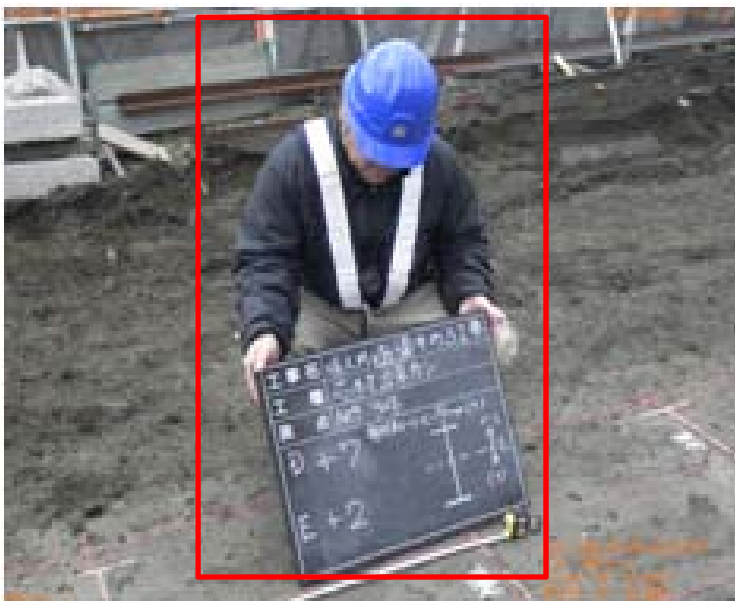
図：現在の工事写真
