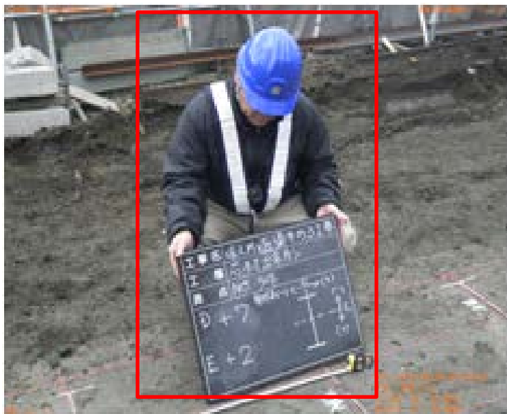
図：現在の工事写真
