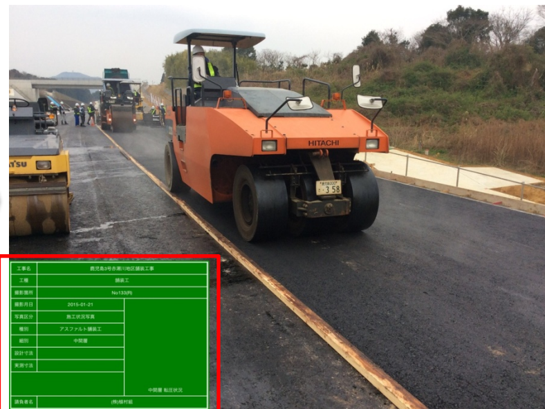
図：試行現場の工事写真
