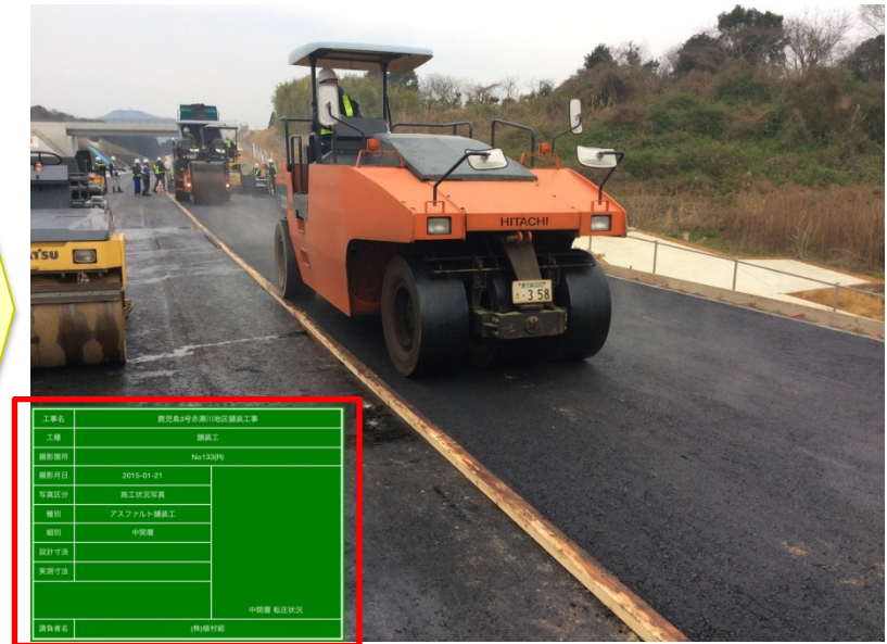
図：試行現場の工事写真
