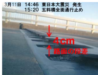
今回の橋面上の段差は、支承の回転移動部である「ローラー」が脱落したことによるもので、抜け出たローラーの高さだけ上部工が下がった。
