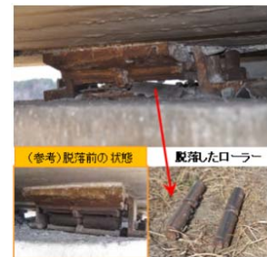
今回の橋面上の段差は、支承の回転移動部である「ローラー」が脱落したことによるもので、抜け出たローラーの高さだけ上部工が下がった。
