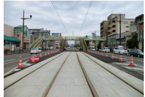
図 3-60 撤去前の状況
