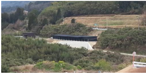
図 4-27 建設されたコア倉庫
