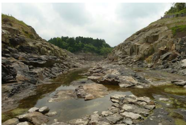
図 3-25 完成した河床の様子（2011/6/2）
