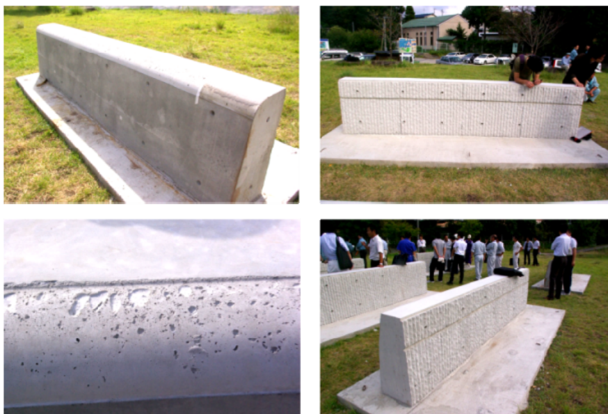
図 4-24 パラペットの試験施工
