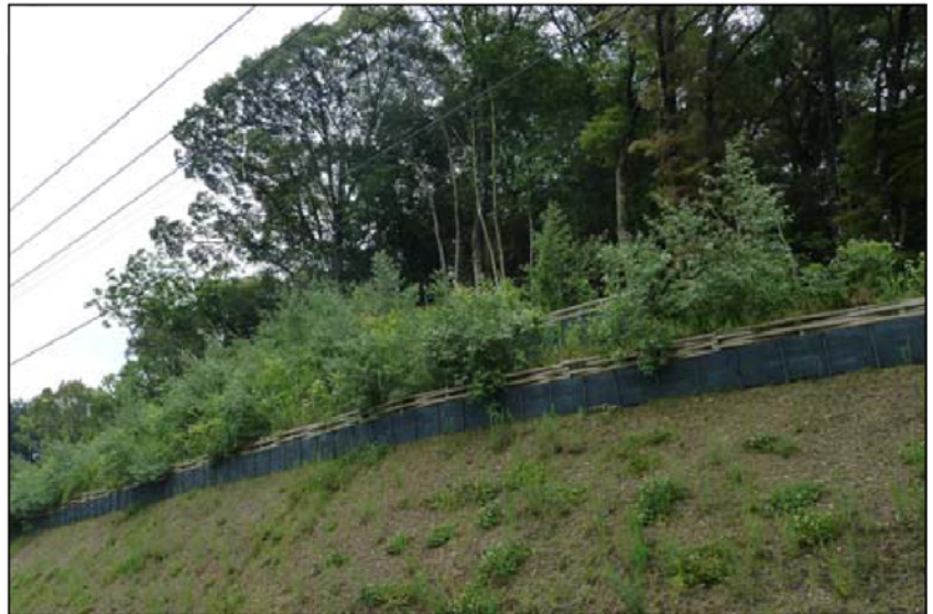
図 3-22 法面植生状況
