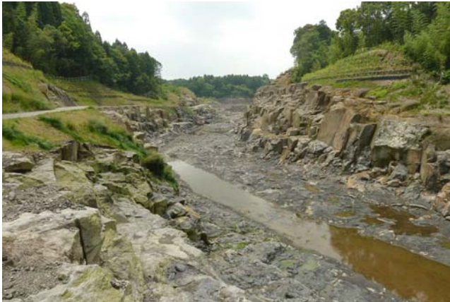
図 3-27 完成した曾木の滝分水路（2011/6/2）
