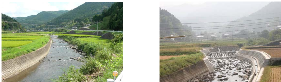
図 4-39 被災前、復旧後
