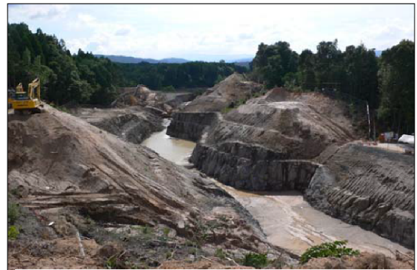
図 3-20 1 次掘削後の状況（2009/7/7）
