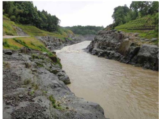
図 3-28 分派する曾木の滝分水路（2011/6/16）
