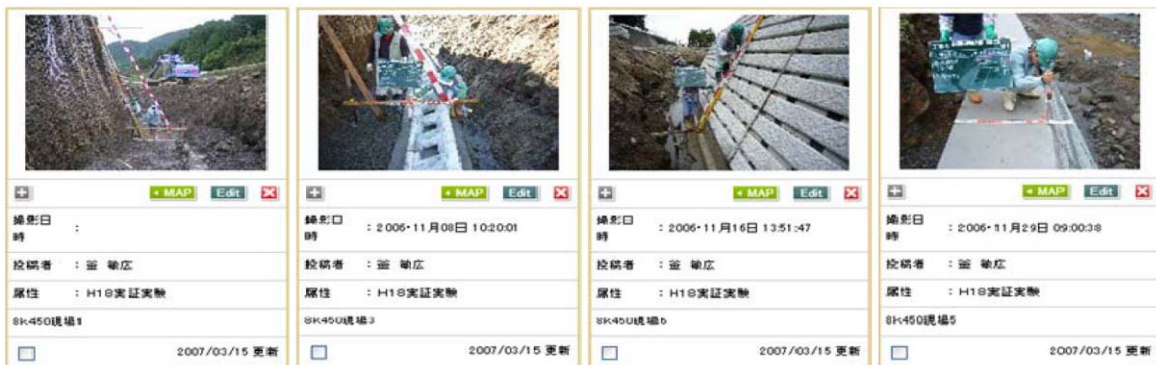
図 4-51 工事進捗確認
