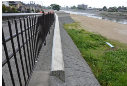
図 4-34 パラペット施工後
