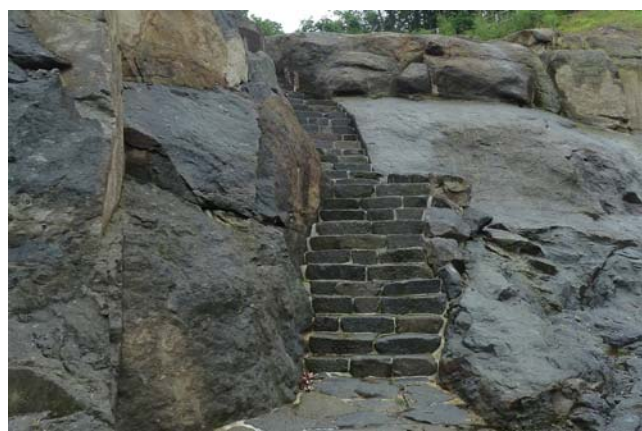
図 3-26 石積みと岩盤に挟まれた階段（2011/6/2）
